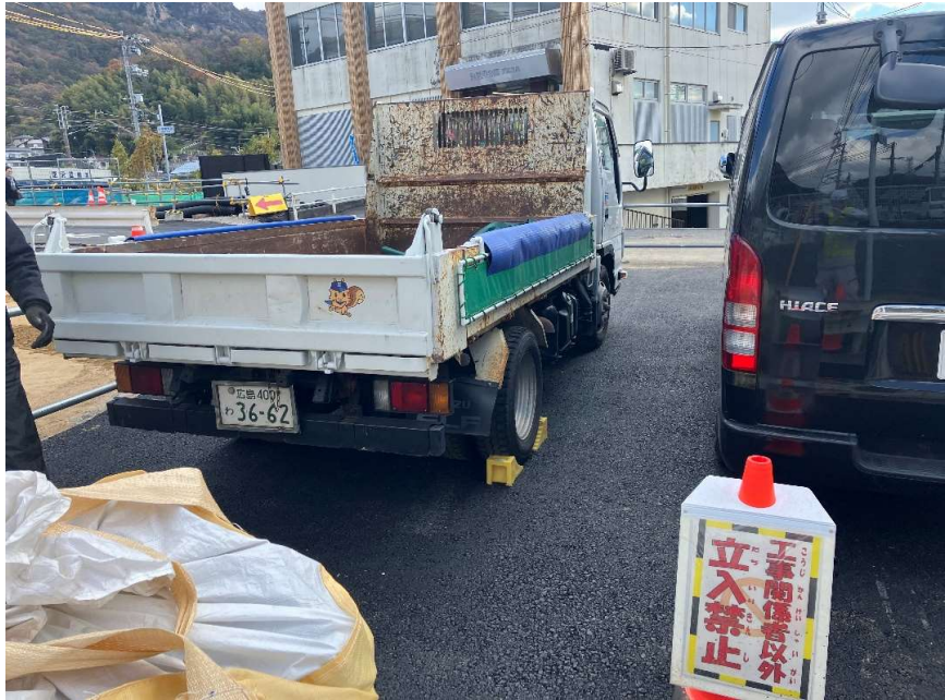
工事関係車両車輪止め設置状況②
