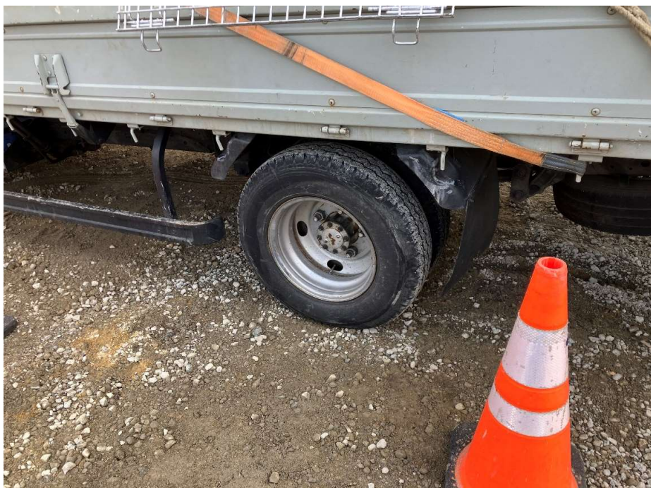
工事車両車輪止め不設置状況
