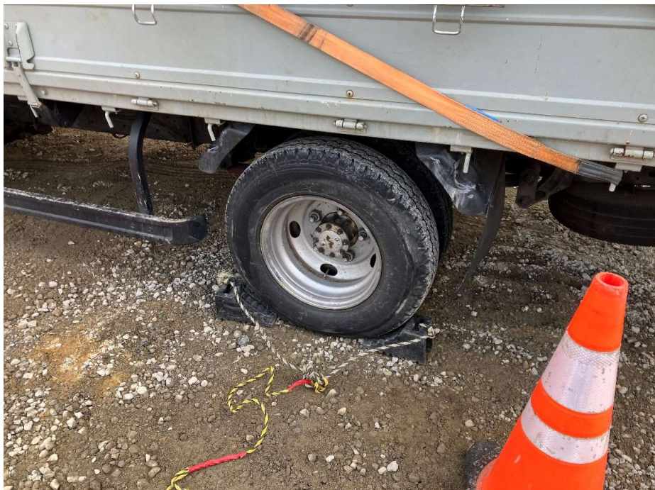
工事車両車輪止め是正状況
